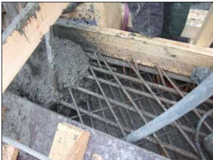
Fig. 11. Blokering blev observeret i forbindelse med støbning af kantbjælker, hvilket nødvendiggjorde omfattende vibrering af betonen.
