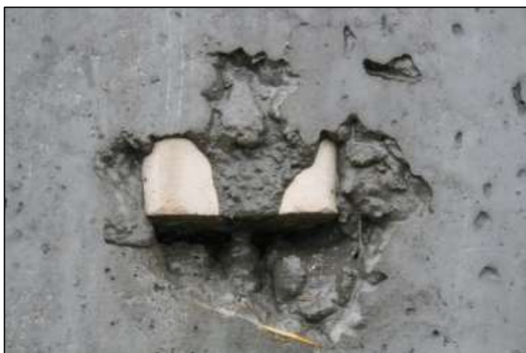
Fig. 8. Eksempel på synlige afstandsklods observeret på ydersiden af brovæg.
