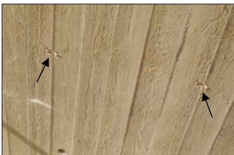
Fig. 9. Eksempler på synlige afstandsklods (markeret med pile) observeret på indersiden af brovæg.
