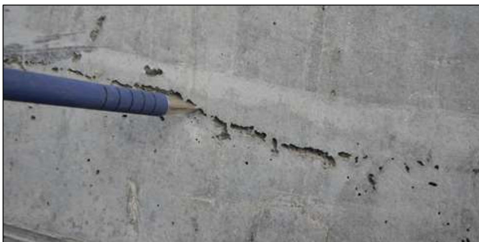
Fig. 32. Detalje fra ydersiden af vestvæg. Linje af luftporer ses ved kuglepennen.
