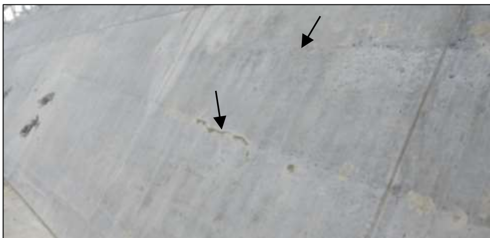
Fig. 31. Yderside af vestvæg. Linjer af luftporer er markeret med sorte pile.
