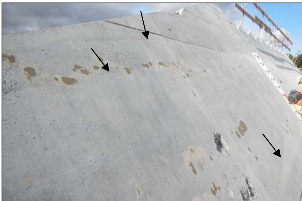
Fig. 25. Yderside af østvæg. Linjer af luftporeansamlinger er markeret med sorte pile.
