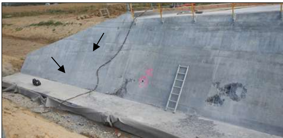
Fig. 28. Yderside af vestvæg. Linjer af luftporeansamlinger er markeret med sorte pile.
