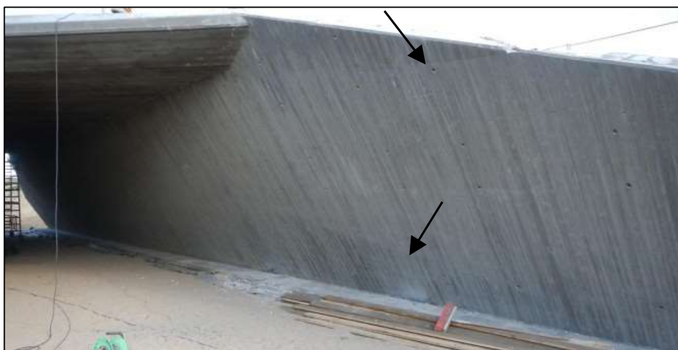
Fig. 26. Inderside af østvæg. Linjer af luftporeansamlinger er markeret med sorte pile.
