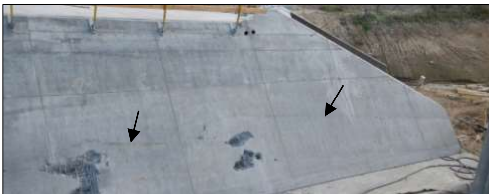
Fig. 30. Yderside af vestvæg. Linjer af luftporeansamlinger er markeret med sorte pile.
