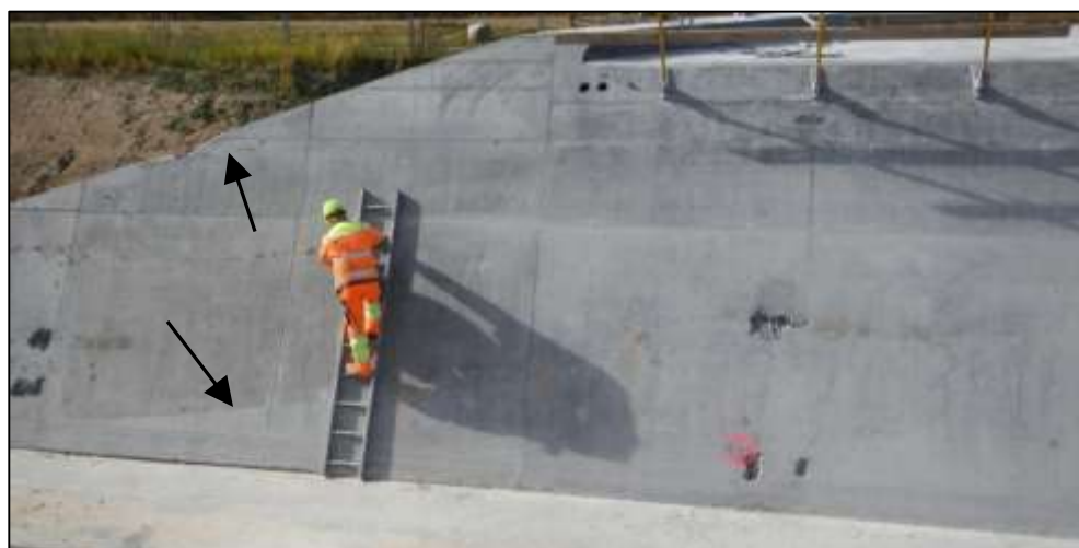
Fig. 24. Yderside af østvæg. Linjer af luftporeansamlinger er markeret med den sorte pil.
