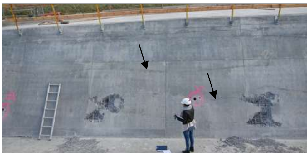
Fig. 29. Yderside af vestvæg. Linjer af luftporeansamlinger er markeret med sorte pile.
