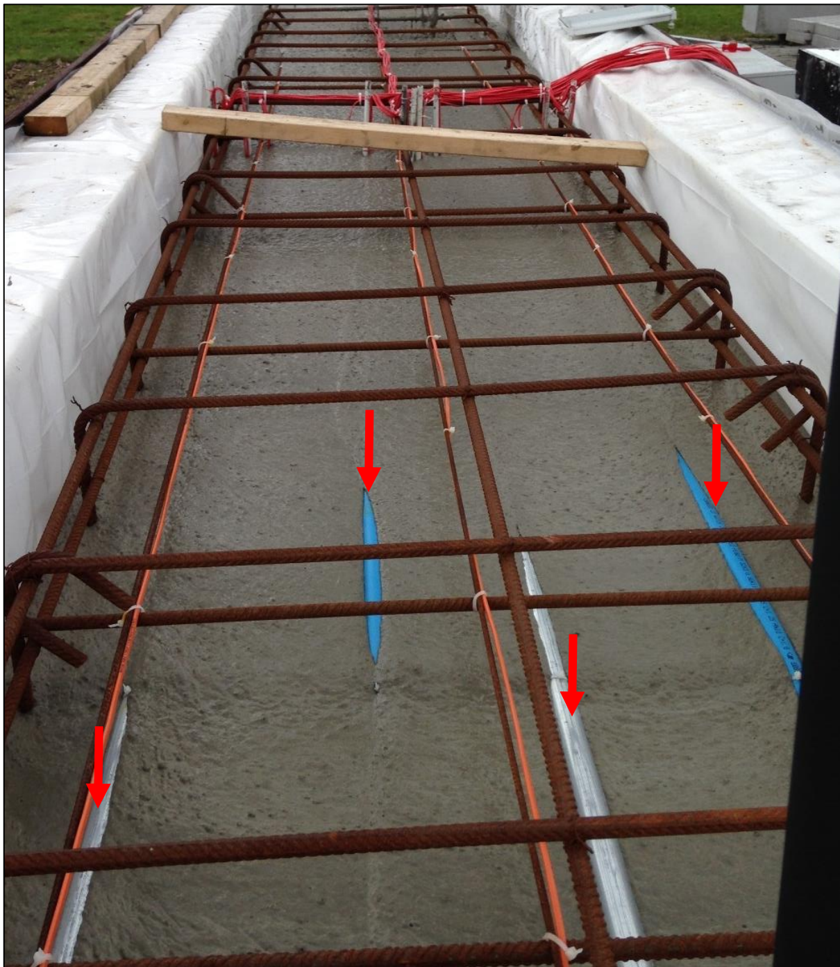
Fig. 2. Eksempel på betonstøbning, hvor der er anvendt køling (markeret med pile). Der er her tale om en teststøbning, hvor forskellen på forskellige typer af kølerør undersøges. Derfor ses der to forskellige typer rør. Der er desuden indstøbt termofølere, således at temperaturen i betonen kan overvåges under hærdeforløbet (røde ledninger øverst i billedet).
