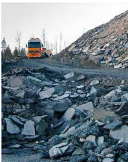
Figur 2. Typisk oplag af gammel opbrudt genbrugsasfalt før nedknusning for genanvendelse [2]
