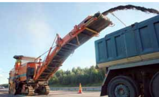
Figur 1. Affræset gammelt slidlagsmateriale bør betragtes som en vigtig ressource til fremstilling af ny asfalt. [2]
