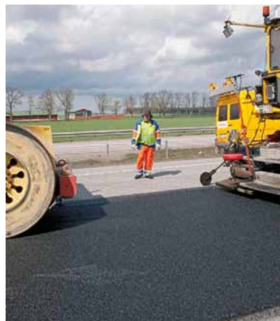
Figur 3. Udlægning af asfalt foretages på eksakt samme vis uanset om der tilsættes genbrug [2]
