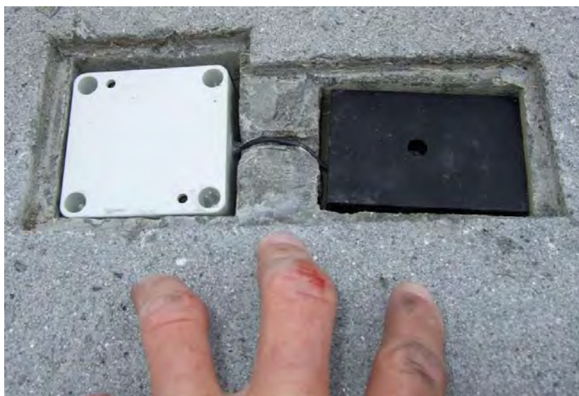
Figur 3. Batteri (venstre) og sensor (højre) placeret i udsparring
