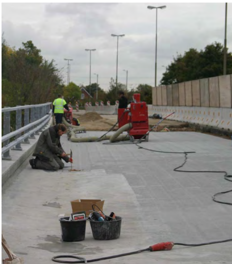
Figur 2. Reparation af brodæk. Halvdelen af brodækket er afspærret imens den reparerer.
