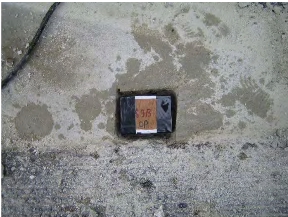
Figur 17. Fotos af installation af sensorer på Skovdiget.
